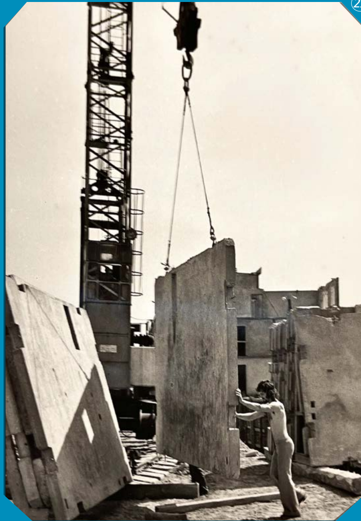
20 21 Na budowie – powstają bloki z wielkiej płyty Zdjęcia: Wiesław Końpa
